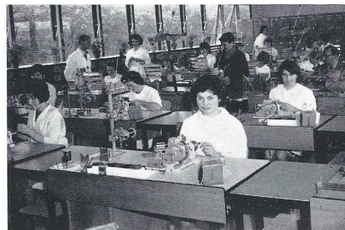
Début de fabrication à l'atelier-pilote de la LTT.
