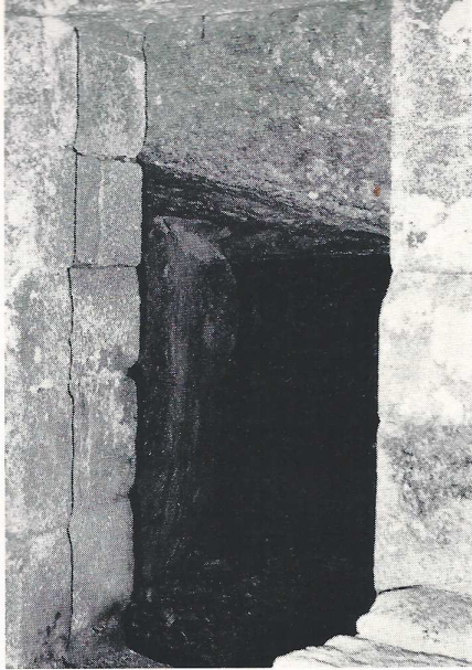
Vue du sous-sol de la chapelle des Sept-Saints au Vieux-Marché.
