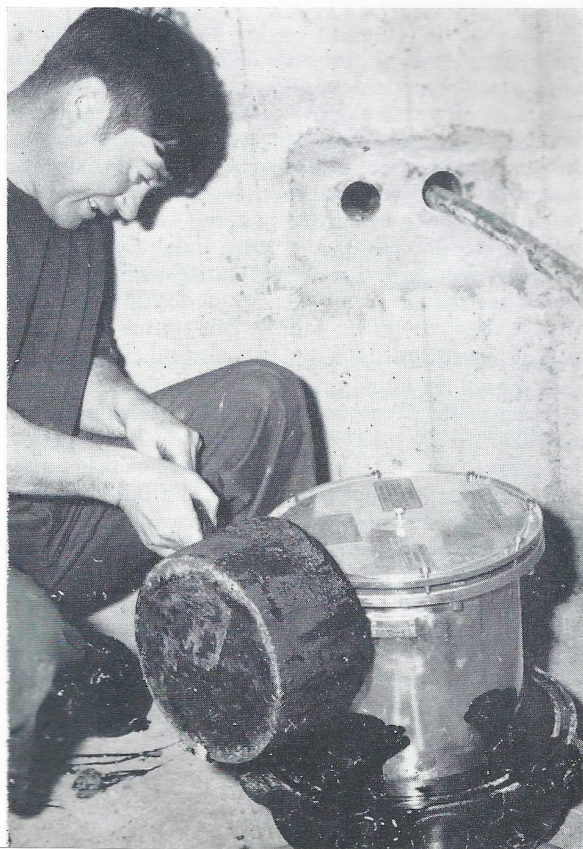
Répéteur-régénérateur installé sur une liaison numérique en câble souterrain
