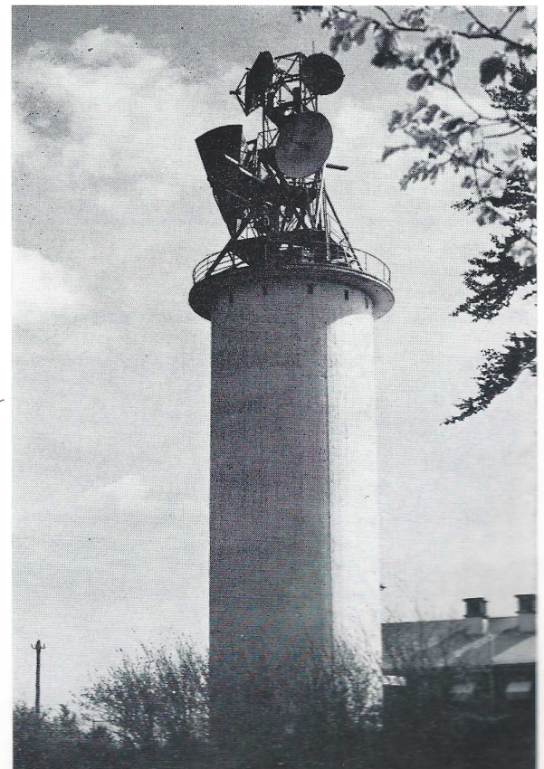
Pylône de faisceau hertzien FHD 22 (Saint-Martin de Chaulieu)
