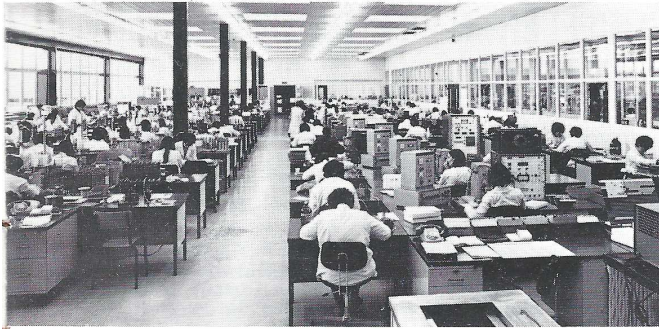
Vue d'ensemble du hall de montage « Matériel 70 »
