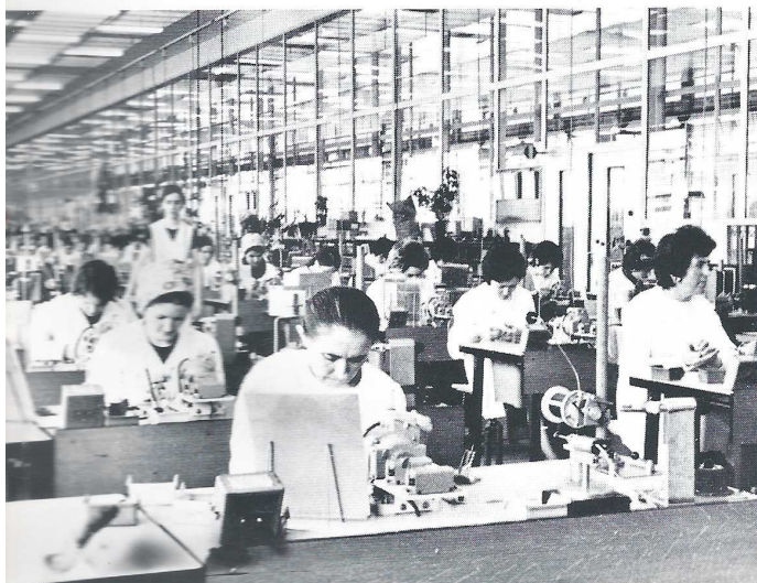
Atelier de bobinage des bobines d'inductance et des transformateurs
