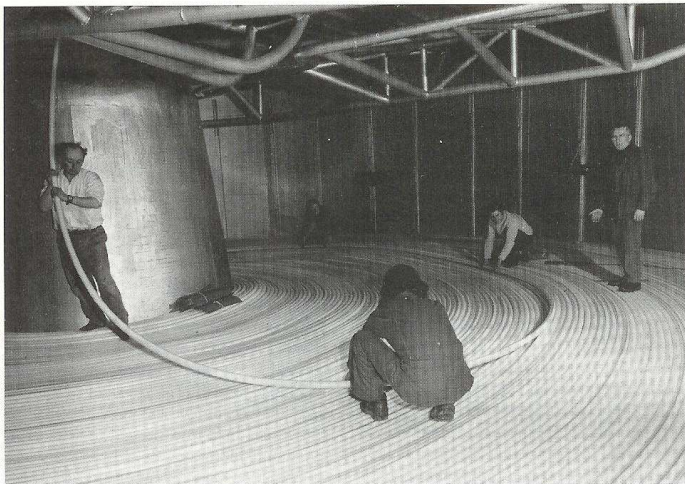
▼ Stockage du câble dans une cuve cylindrique du navire (capacité d'une cuve centrale : 370 km de câble de grand fond).
